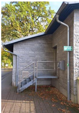
Defibrillator am Wasserhochbehälter der Stadtwerke Backnang beim Waldheim
